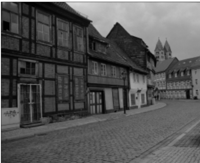
Die Bakenstraße in Halberstadt, vorn links das Haus Nr. 56
