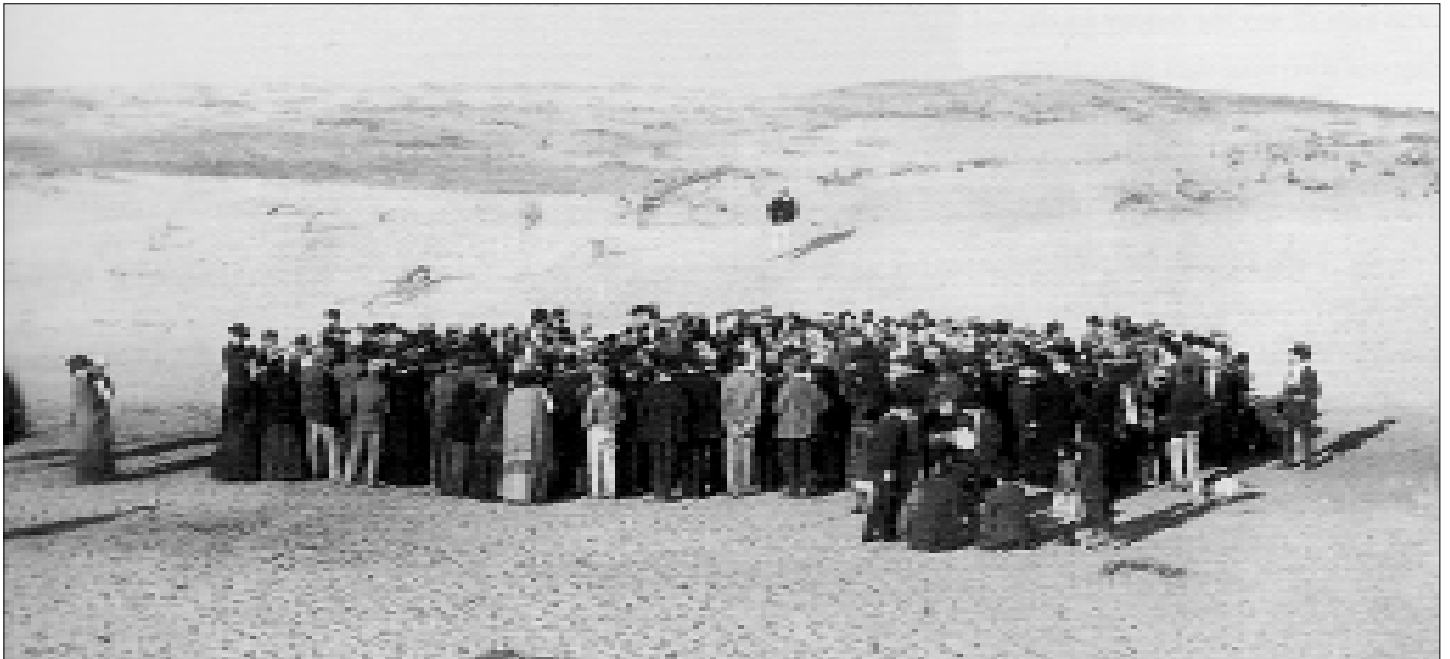
Grundsteinlegung von Achusat Bajit 1909
