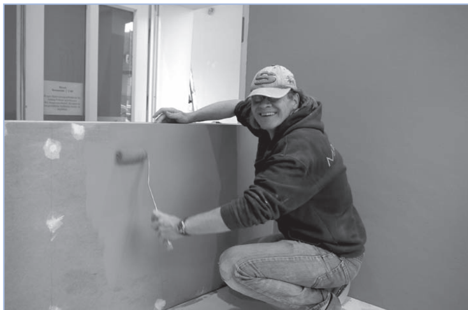
Die Renovierungsarbeiten im »MuseumsKaffee Hirsch« sind fast abgeschlossen.
