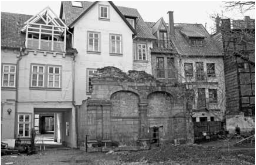
Überrest der zerstörten Halberstädter Barocksynagoge, dahinter links das ehemalige Kantorhaus
